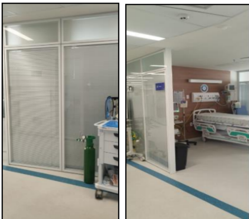
Figura 4 - Detalhe das divisórias dos leitos em vidro, alumínio e persianas embutida
