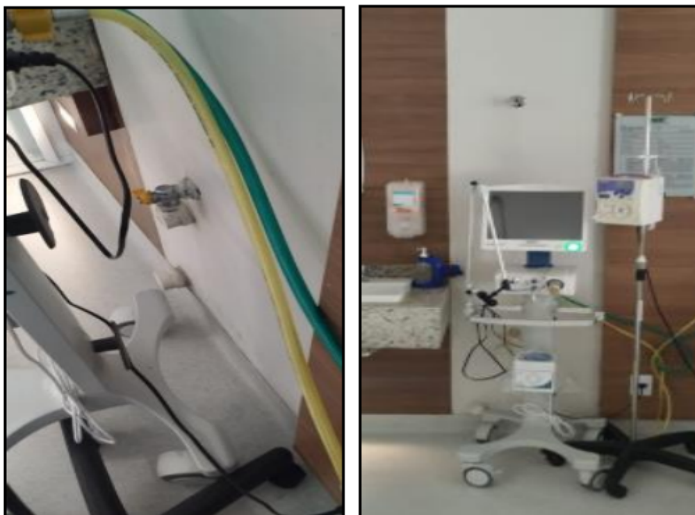
Figura 6 - ponto de água e esgoto para equipamento de hemodiálise.
