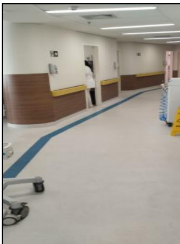
Figura 7 - detalhe da formica e bata maca instalado nos corredores
